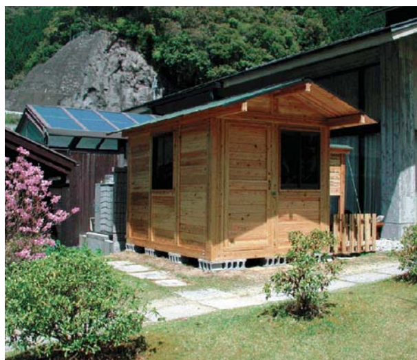
図1 十津川村ホテル昴の郷に設置したキャビン
