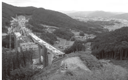
建設が進む新東名高速道路（右奥は新城市街）
